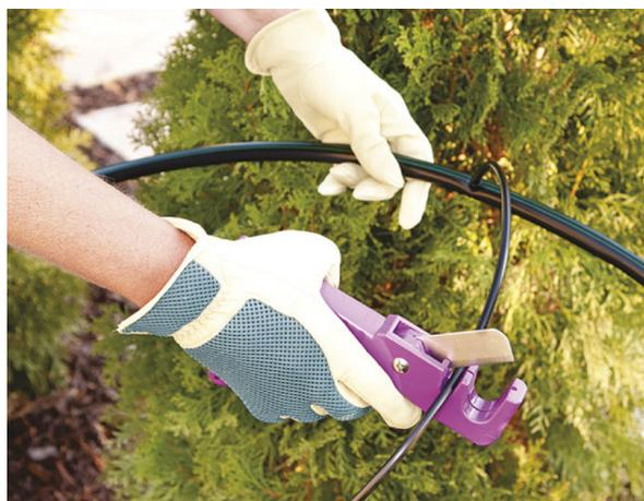
**5** Agora corte um pedaço de tubo de 1/4" e use uma conexão de 1/4" para encaixá-lo no tubo de distribuição.
