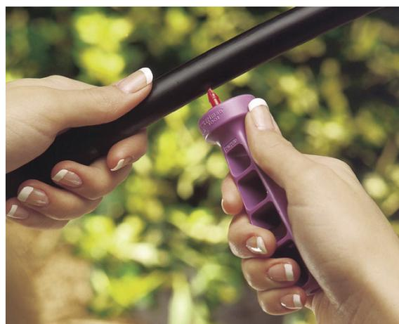
**4** Para instalar o tubo de 1/4", que levará a água diretamente até uma planta, faça um furo no tubo de distribuição com a ferramenta de instalação.
